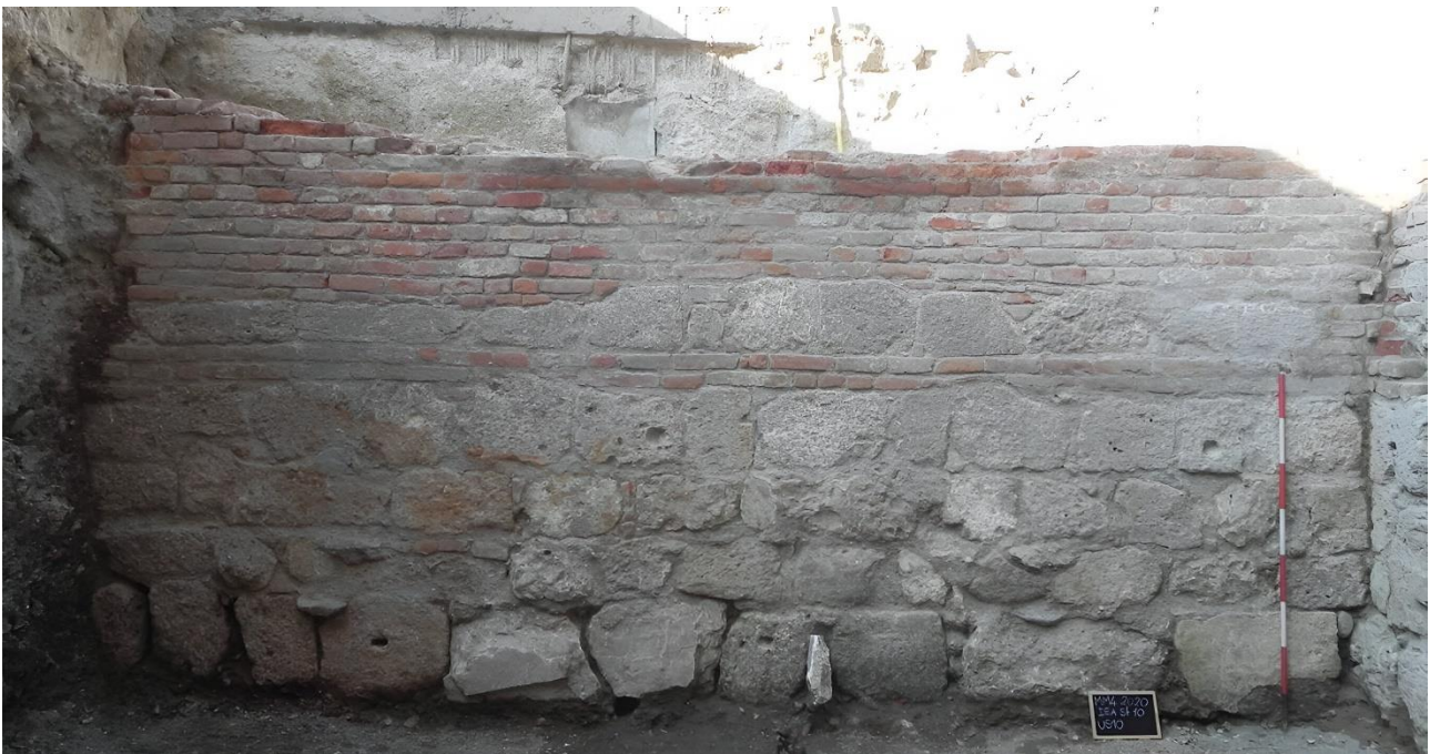
Muratura interna della torre – The internal masonry of the tower
