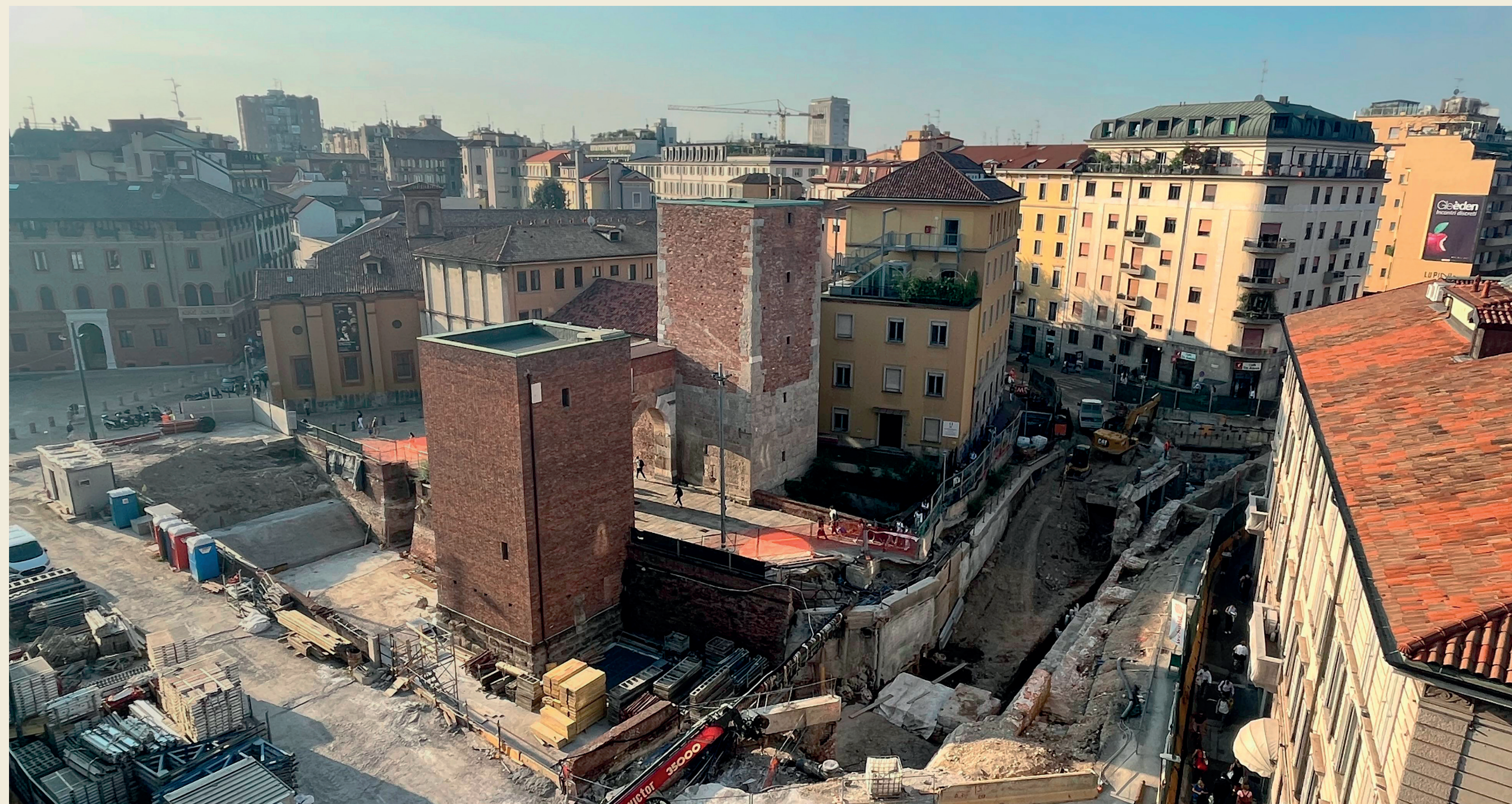
Pusterla di Sant'Ambrogio durante i lavori M4 Pusterla di Sant'Ambrogio and M4 construction site
