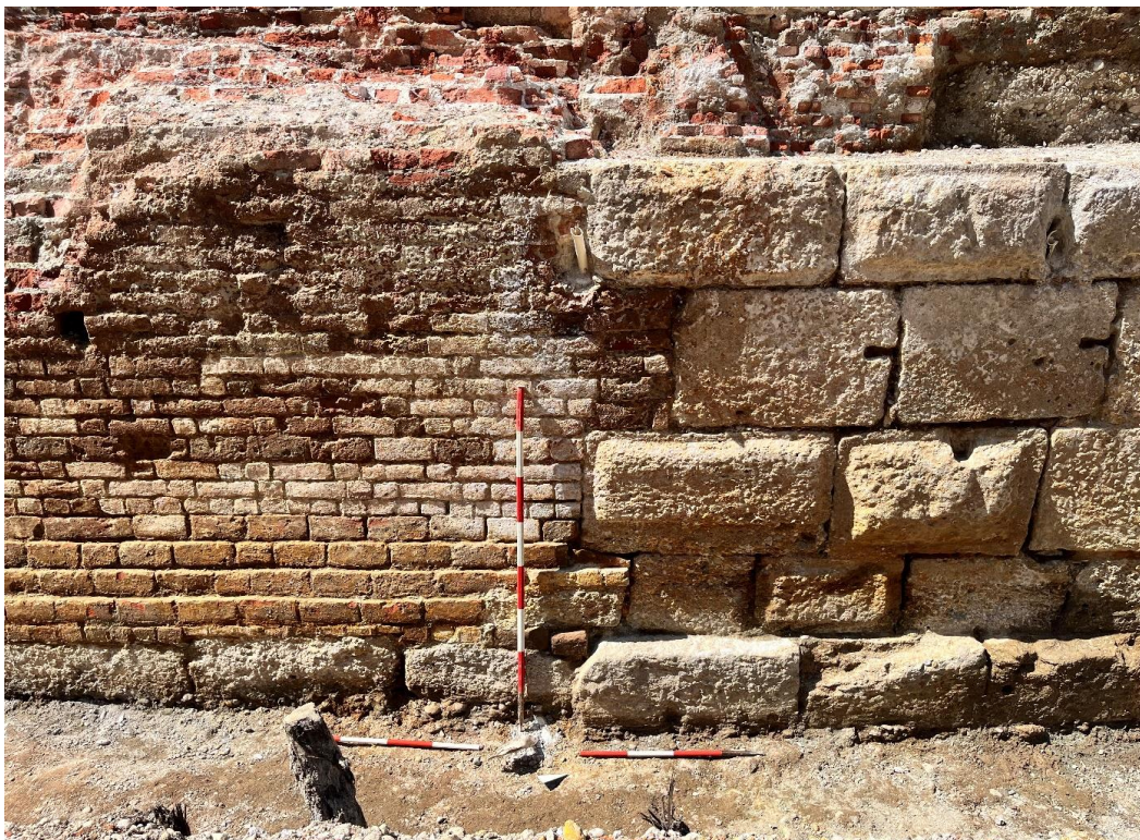
Argine esterno del naviglio: a destra la muratura originale rivestita in pietra, a sinistra il rifacimento di età moderna in laterizi / External bank of the canal: on the right, the original stone-clad masonry; on the left, the modern brick reconstruction.
