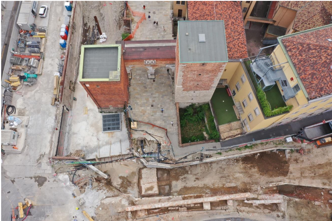
Via Carducci. La pusterla di sant'Ambrogio e le strutture medievali rinvenute nel cantiere per la costruzione del corridoio di collegamento tra le linee M2 e M4 / Carducci Street. The Sant'Ambrogio pusterla and medieval structures found at the construction site for the connection corridor between Metro lines 2 and 4.
