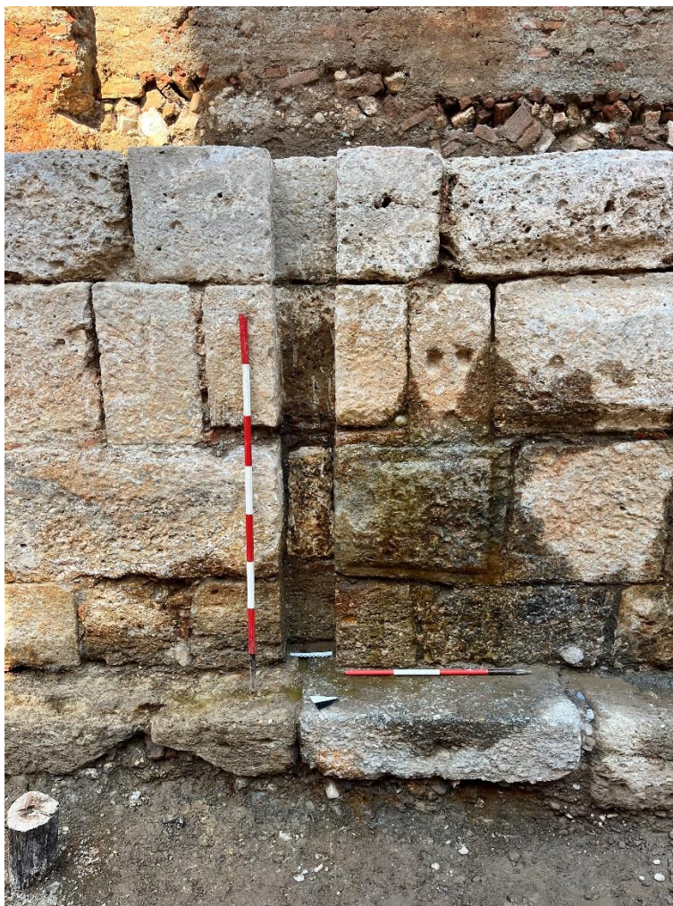
Muratura dell'argine esterno del naviglio / Detail of the masonry of the external bank of the medieval canal.
