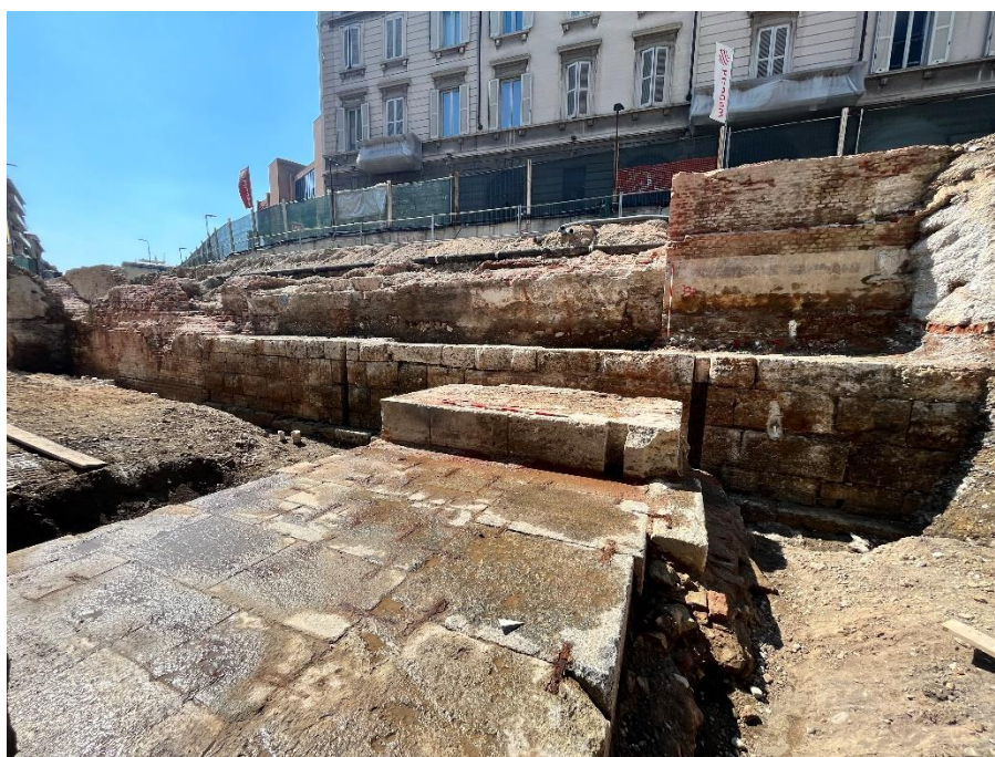
Strutture costruite sul fondo del naviglio in fase di scavo. / Structures built on the bottom of the canal during the excavation phase.
