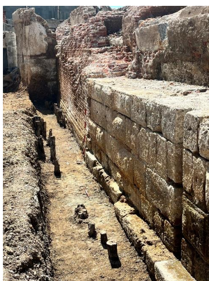
Argine esterno del naviglio: visibili pali di legno a sinistra, a destra fase costruttiva più recente (XIX sec) / External bank of the canal: wooden piles are visible at the base. External bank of the canal: detail of the most recent construction phase (19th century)
