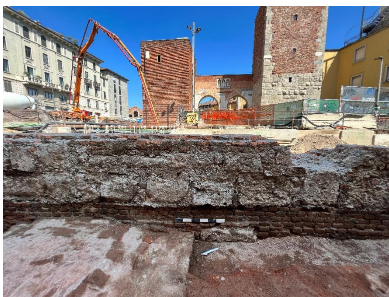
Argine esterno del naviglio: visibili pali di legno a sinistra, a destra fase costruttiva più recente (XIX sec) / External bank of the canal: wooden piles are visible at the base. External bank of the canal: detail of the most recent construction phase (19th century)
