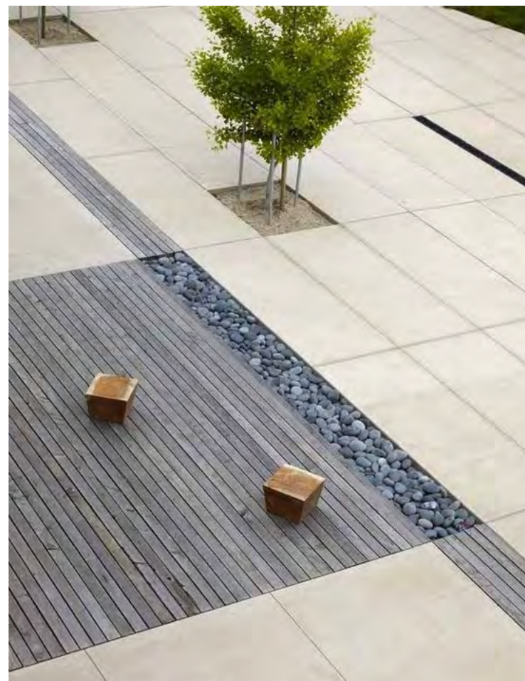
Fig.67: Composizione pavimentazioni: lastricato e legno composito
