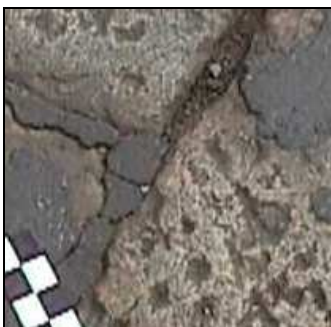
Figura 13: Asportazione di sigillante dai giunti
