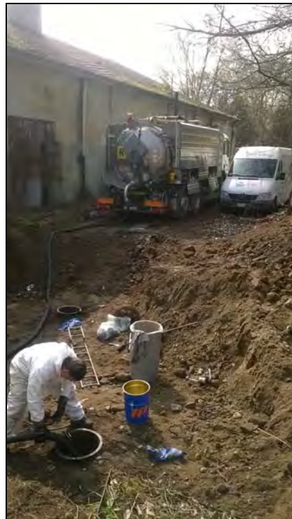
Foto 2: Operazioni di bonifica (svuotamento e lavaggio).
