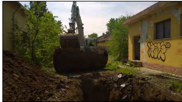
Foto 6: rimozione serbatoio 1
