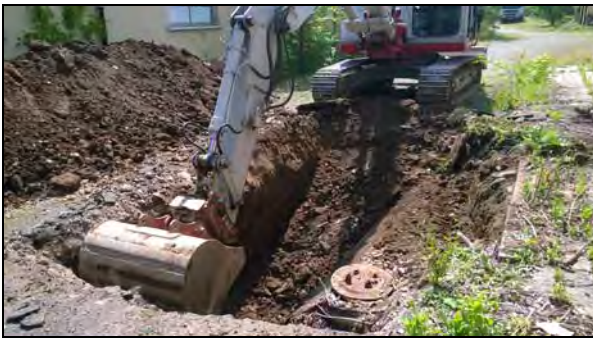
Foto 5: scavo per rimozione serbatoio 1
