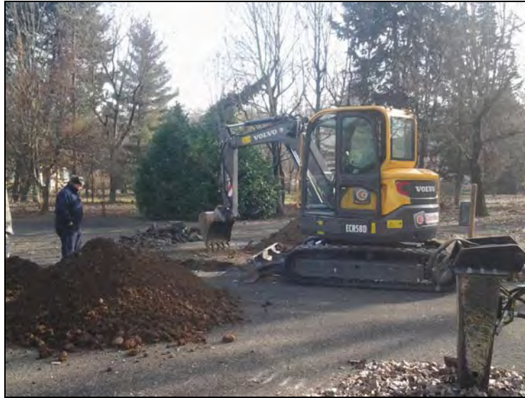
Foto 1: Escavatore Volvo mod. ECR58D su Trincea T2
