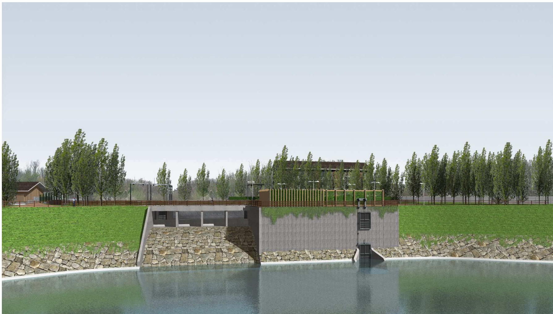
Area manufatti di presa, scarico e cabina elettrica – Vista dall'interno dell'invaso
