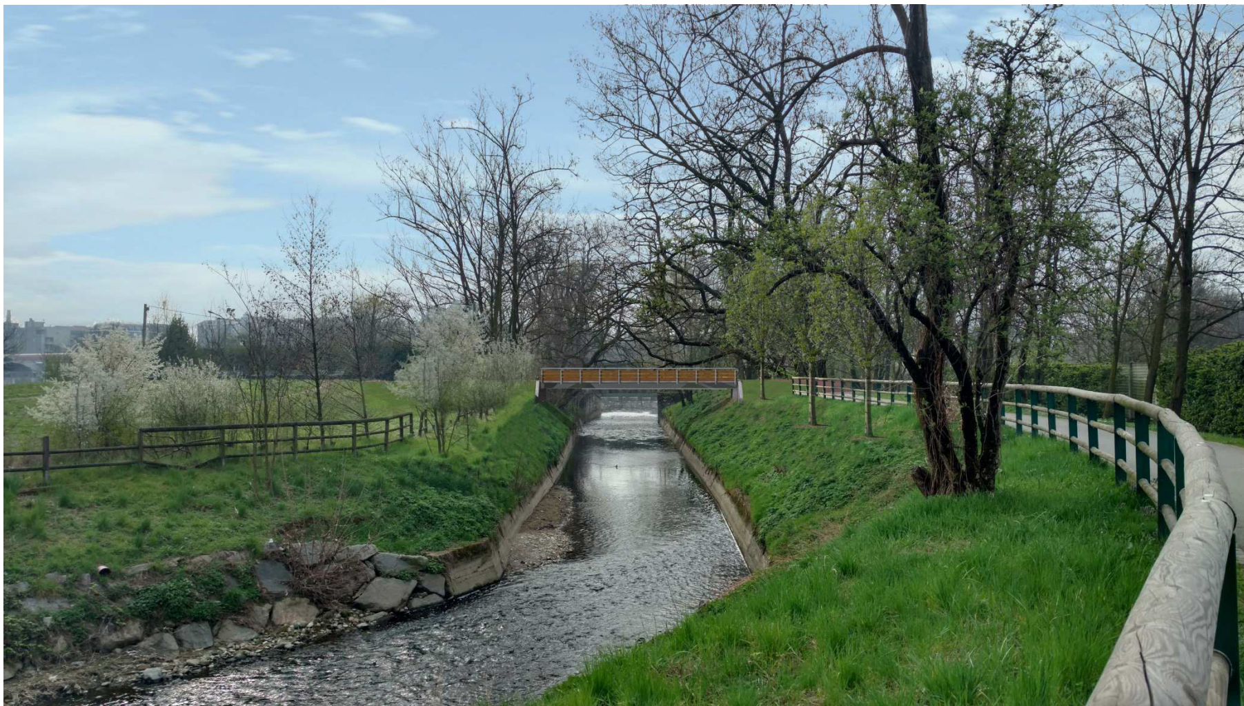
Nuovo ponte manutentivo
